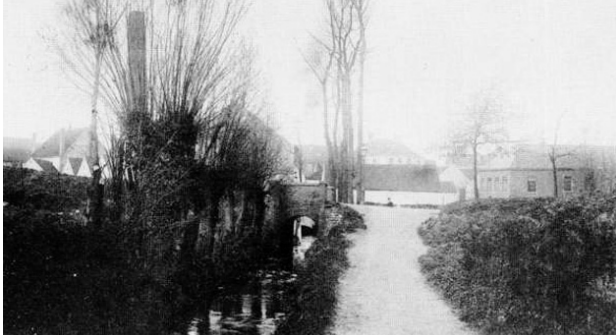
L'aqueduc sur la Woluwe
